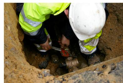
Exemple de réparation de branchement – dans le cas présent remplacement du « robinet de prise en charge & d'arrêt » défectueux.
