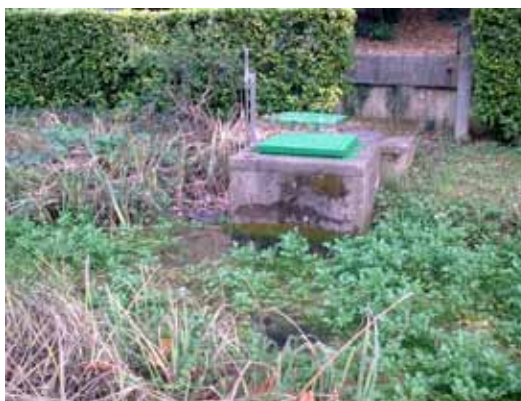
Figure 17 : captage à Maromme
