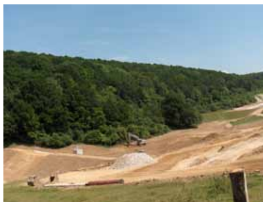
Figure 10 : ouvrage à Roncherolles-sur-le-Vivier
