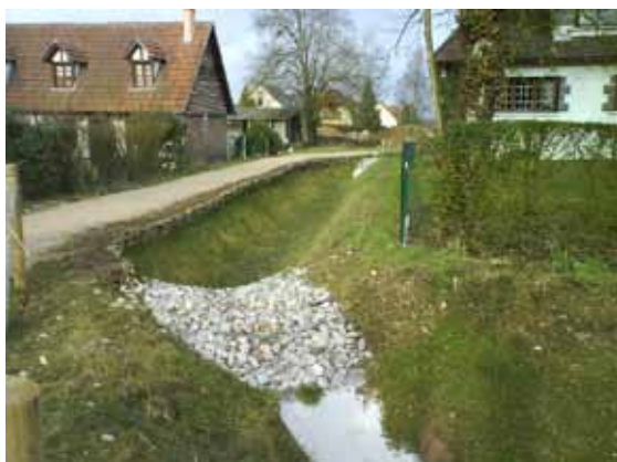
Figure 9 : ouvrage à Saint-Jean du Cardonnay
