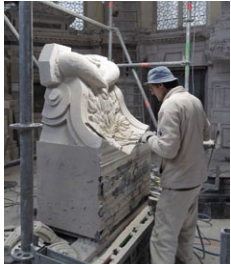
Restauration des décors intérieurs en pierre sculptée
